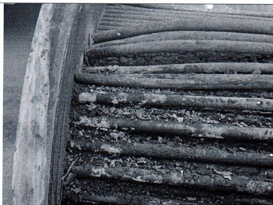
Foto 2. Placa tubulara – camera distributie spatiu tevi – RK2013
